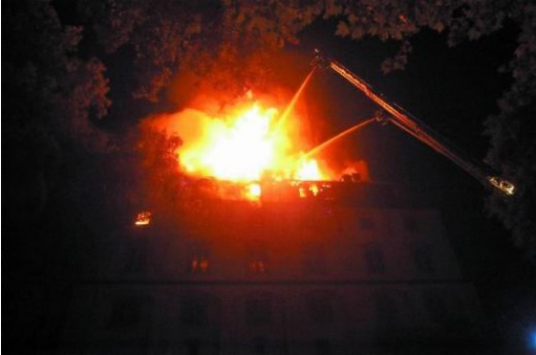
Abb. 9: Die Luftströmung bringt frische Luft zum Brandherd und sorgt somit für eine gelbe Flamme
