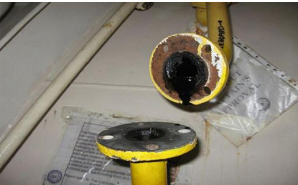
Abb. 2: Reinwasserleitung vom Bilgenwassertöler nach See. Hier dürften nur geringe Ölanteile vorzufinden sein.
